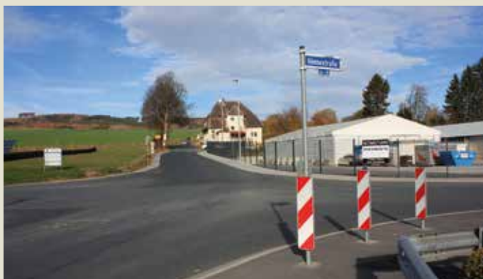
Endlich hat Küntrop einen sicheren Bahnübergang inklusive sicherem Zuweg erhalten. Lange hat es gedauert, bis die letzten Baustellenschilder aus dem Weg geräumt wurden, aber im Frühjahr 2015 war es endlich soweit.
